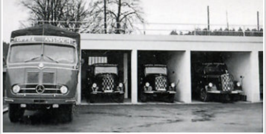
Die Garage in der Oberhäuser Straße wurde später zur Werkstatt umgebaut. Reparaturen führten die Oppels in eigener Regie aus, zunächst leitet Adolf Oppel die Instandsetzungsarbeiten
